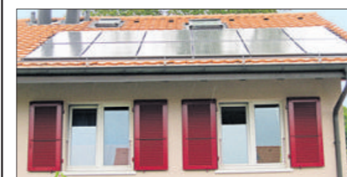
M me et M. S., 1213 Onex Centrale photovoltaïque 3 KWC et solaire thermique
