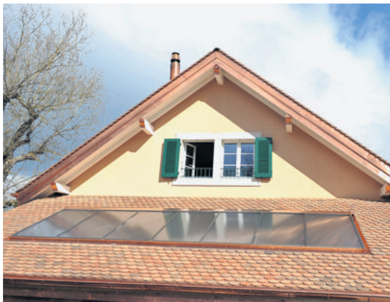
Une installation solaire de 4 à 6 m 2 de capteurs peut couvrir près de 70% des besoins d'eau chaude d'une famille de 4 personnes. PIERRE ABENSUR
