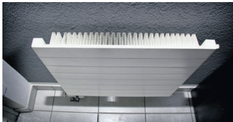
Les pompes de circulation charrient l'eau sortant de la chaudière dans le circuit de distribution de chaleur, permettant à celle-ci de se refroidir peu à peu à travers les radiateurs pour réchauffer l'air des locaux. P. BATTISTON
