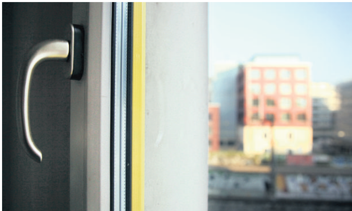
Certaines fenêtres à triple vitrage peuvent permettre d'économiser plus de 50 litres de mazout par an par mètre carré de fenêtres ainsi équipées. PAOLO BATTISTON
